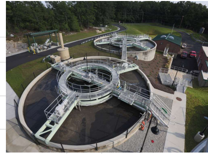
Sturbridge WWTP, MA
